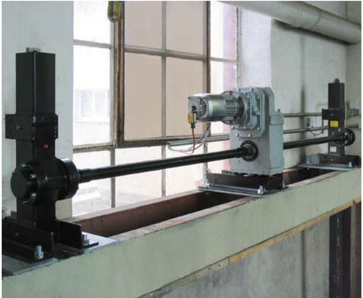
PORTE DE HANGAR
